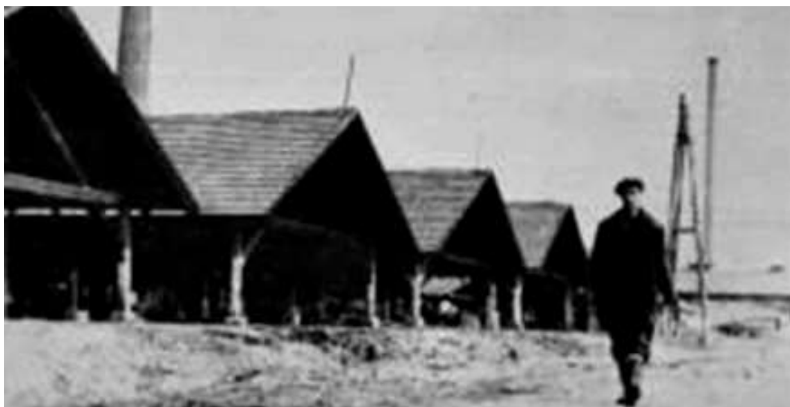
În fotografie se văd șoproanele de uscare a cărămizilor, înainte de arderea în cuptor
